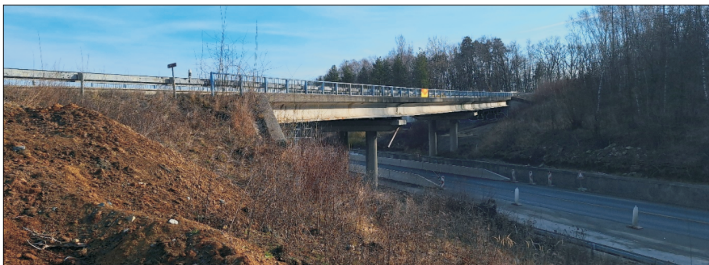
most Vysoká – Dub: před demolici
