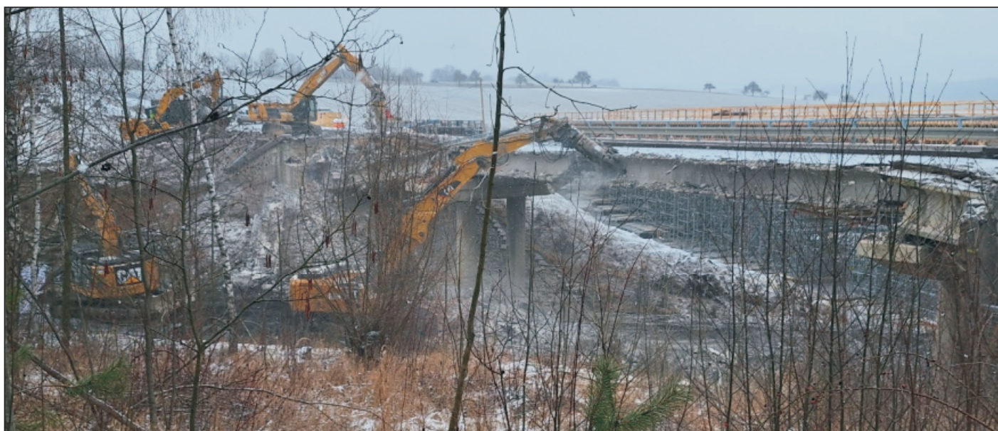
most Vysoká – Dub: průběh demolice
